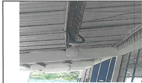
Foto 4: Sistema eléctrico instalado y finalizado
