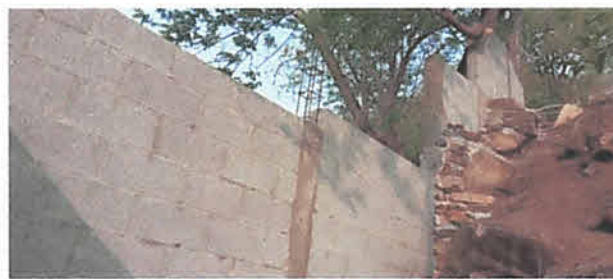
Foto 5: muro perimetral finalizado
