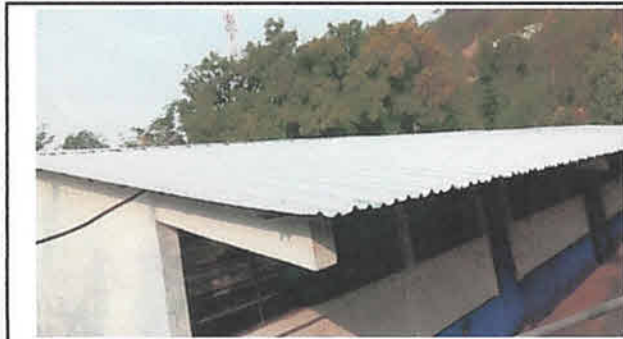
Foto1: Cambio de duralita por lamina troquelada finalizado
