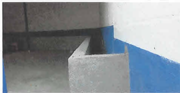
Foto 3: cuneta de concreto finalizada
