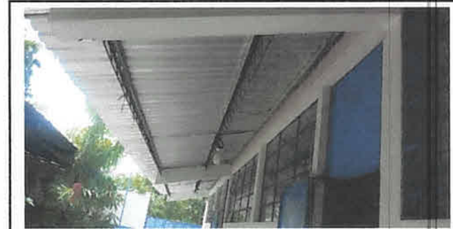
Foto 6: anclaje de costaneras galvanizadas sobre jois finalizado
